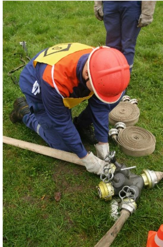
Der Schlauchtruppführer kuppelt den C-Druckschlauch am Verteiler an und öffnet den Druckabgang. Der Schlauchtruppmann bleibt am Verteiler beim Schlauchtruppführer stehen.
